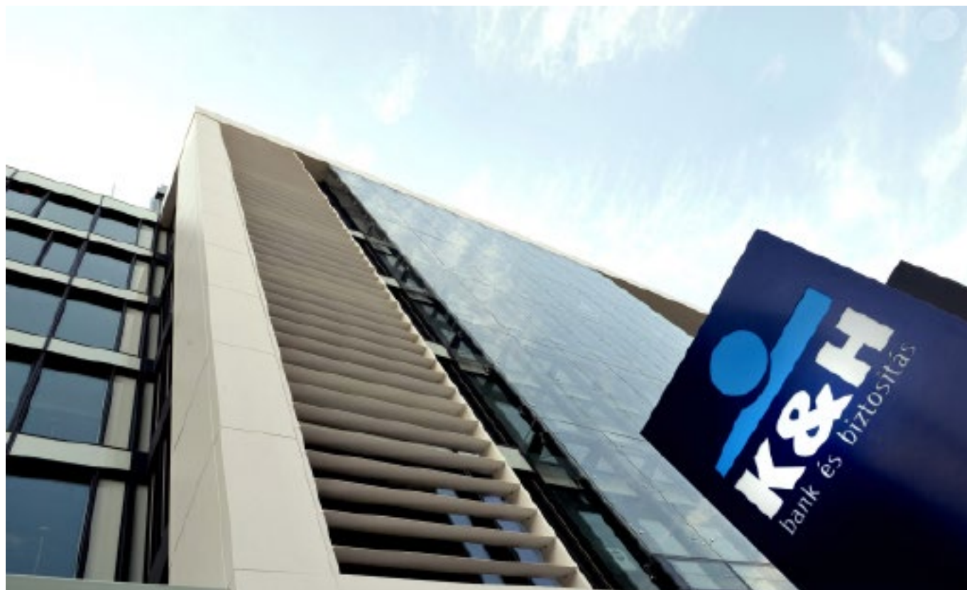
Le siège central de K&H en Hongrie.
